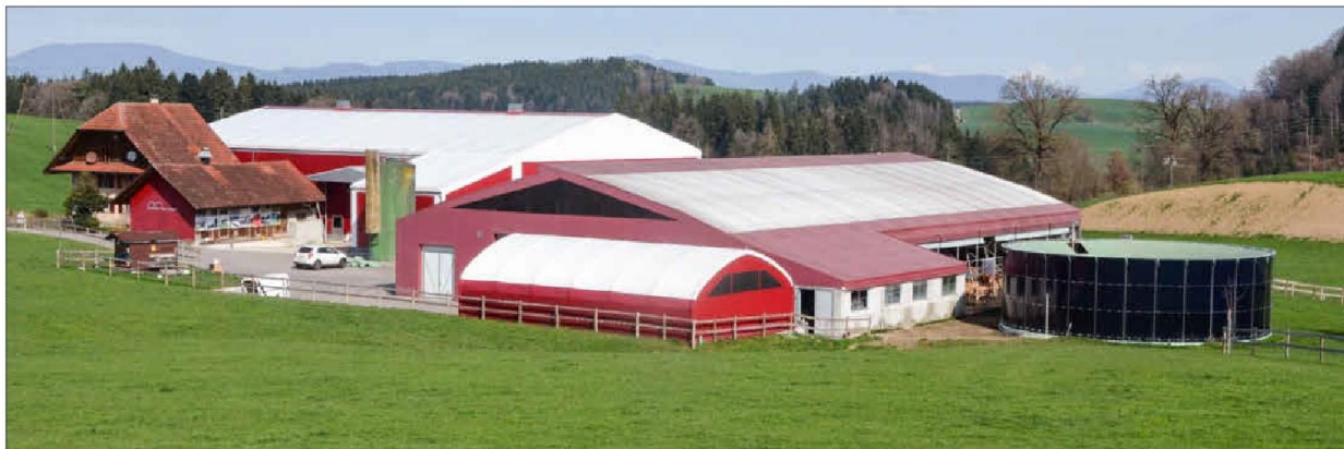
Stützenfreie Hallen für Vieh und Maschinen: Betrieb Peter Häfliger in Altbüron. (Bilder: rh)
