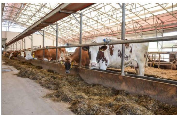
Licht und Luft im Stall und bis zu 80 Meter stützenfrei: Einzige die Abwurffütterung braucht Pfosten.
