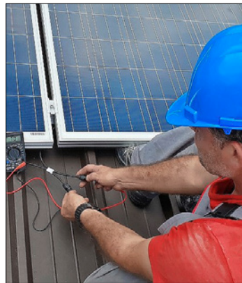
Auch ein Kurzschluss verursacht Kosten. (Bild: Alex Csiki)
